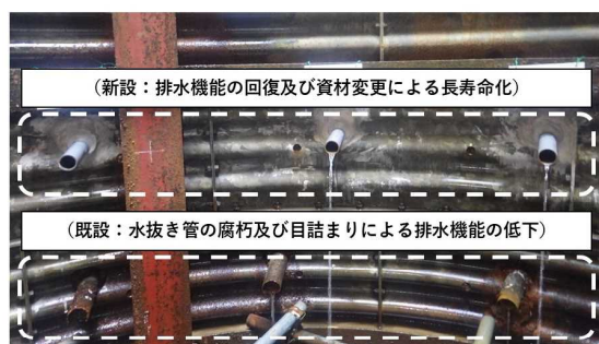
〈図〉長寿命化対策（水ボーリング工）
